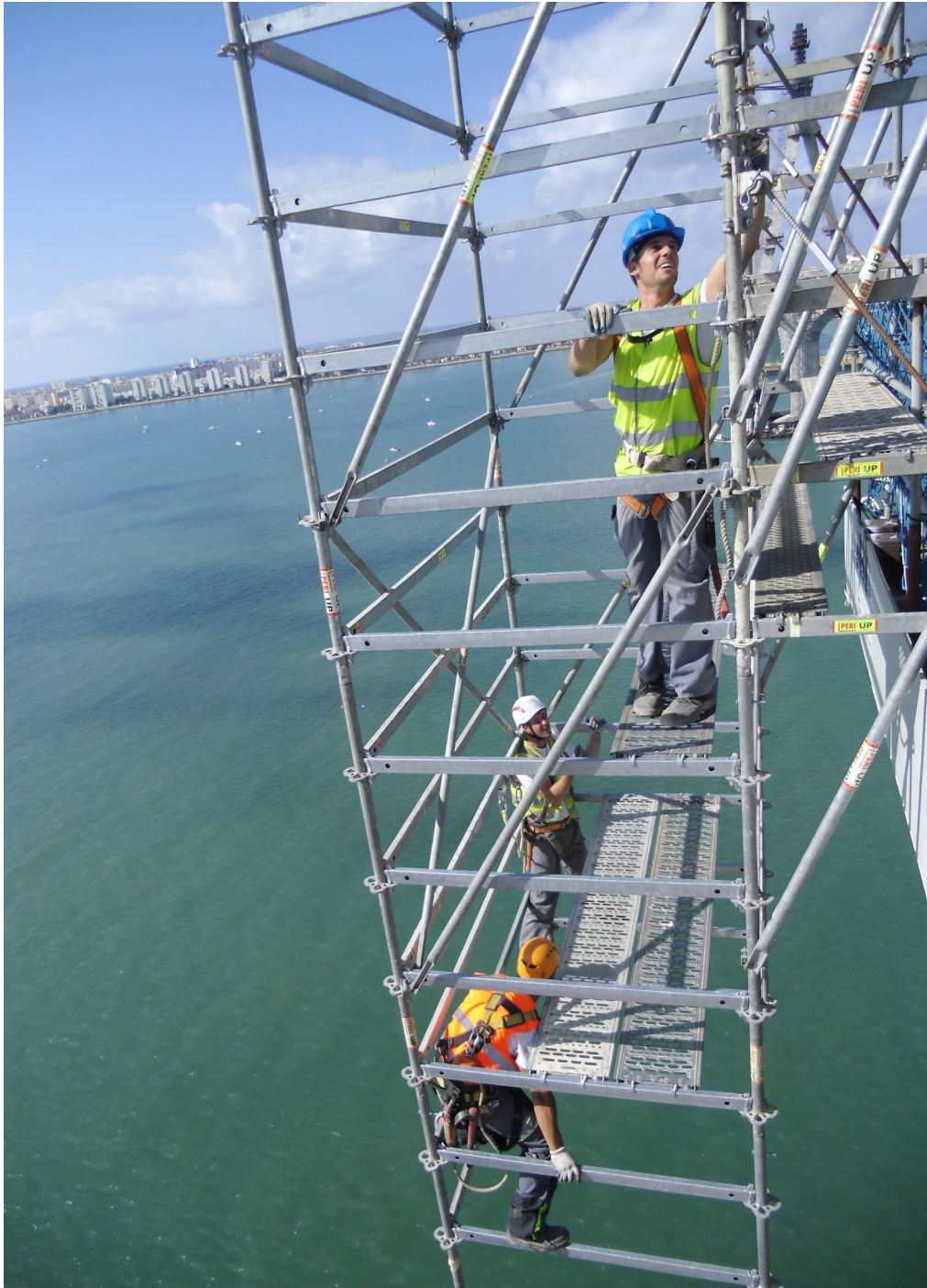
INSTALACIÓN DE ANDAMIOS PARA TRABAJOS DE TESADO BAJO TABLERO NUEVO PUENTE SOBRE LA BAHÍA DE CÁDIZ
